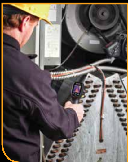
Ispezioni di sistemi di condizionamento (HVAC)
